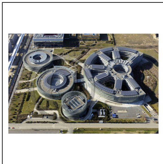
91 Essonne Région Île-de-France / Plateau de Saclay : Le campus urbain Paris-Saclay à Palaiseau / Le centre EDF Lab Paris-Saclay (Recherche et Développement) dans le quartier de l'Institut Polytechnique de Paris (F.Soler architecte 2016) *** Local Caption *** The plateau of Saclay: The campus Paris-Saclay in Palaiseau / The district Polytechnique / The R&D department of EDF ( designed by F.Soler architect 2016)/ 91 Essonne Région Île-de-France
