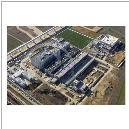
91 Essonne Région Île-de-France / Plateau de Saclay : Le campus urbain Paris-Saclay / Quartier de l'Institut Polytechnique de Paris / Construction de l'hôpital d'Orsay / Le métro Grand Paris Express ligne 18 en arrière plan et à gauche de l'image *** Local Caption *** The plateau of Saclay: The new hospital of Orsay under construction / 91 Essonne Région Île-de-France
